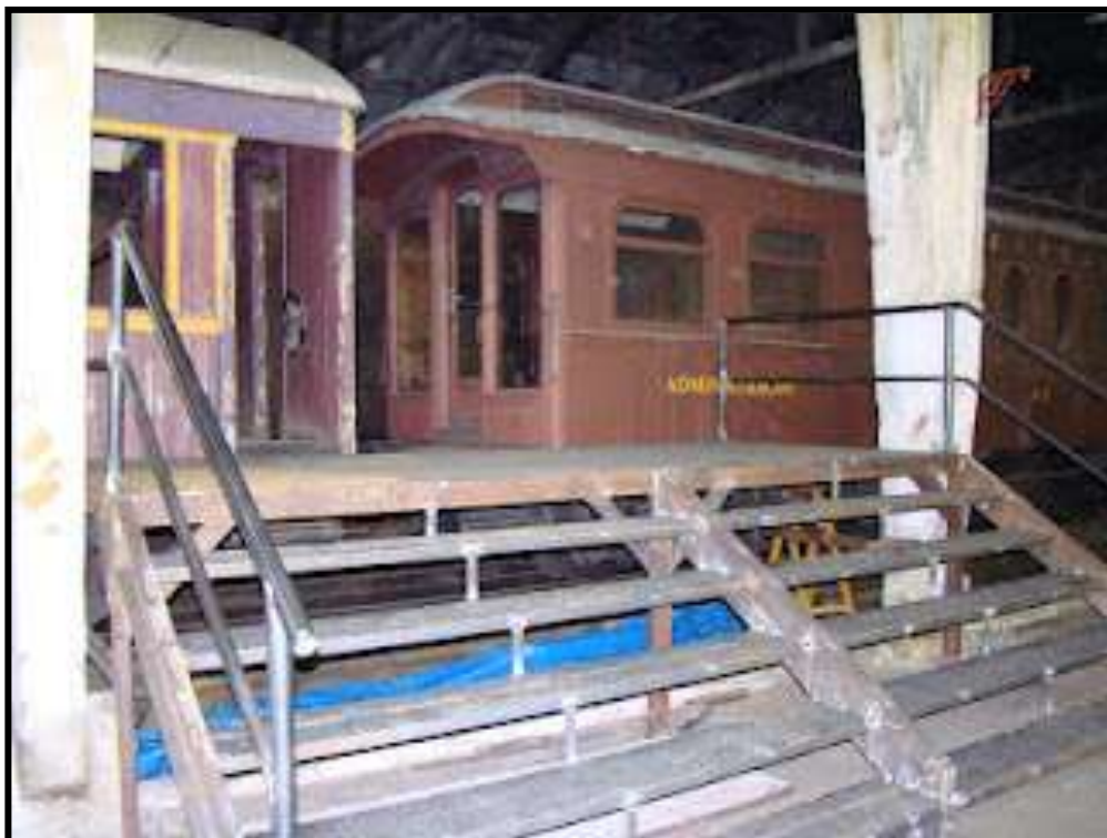
A plataforma de embarque e desembarque já finalizada.
