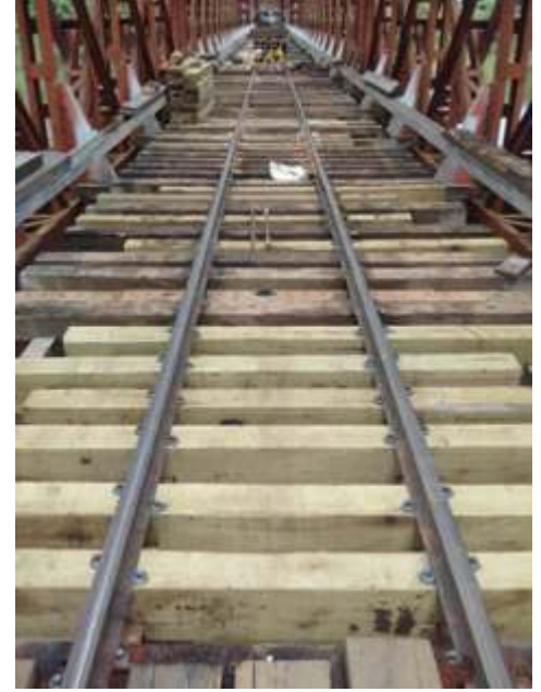
Os trabalhos de substituição dos dormentes na ponte sobre o Rio Pelotas
