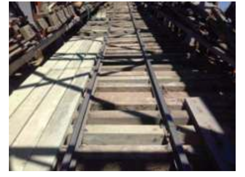
Substituição de dormentes e a recolocação do assoalho na ponte que atualmente é rodo ferroviária
