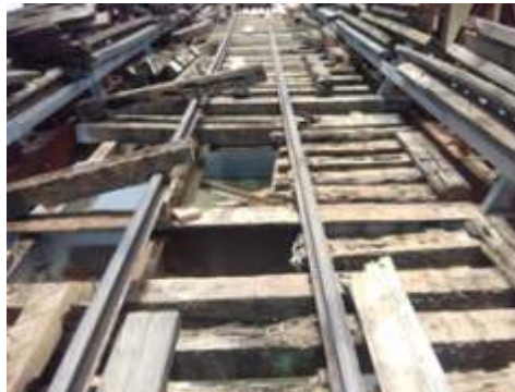
Substituição de dormentes e a recolocação do assoalho na ponte que atualmente é rodo ferroviária
