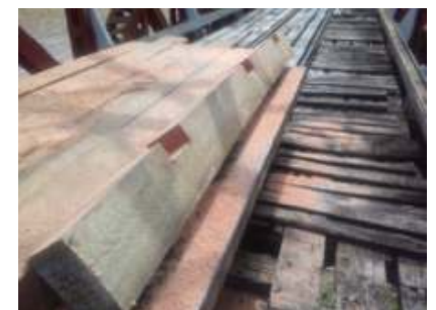
Os velhos dormentes aos poucos estão sendo trocados por novos que são talhados um a um
