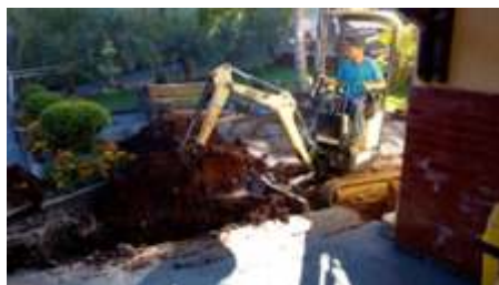
Os trabalhos de montagem de rede de canos para saída dos dejetos do novo sanitário
