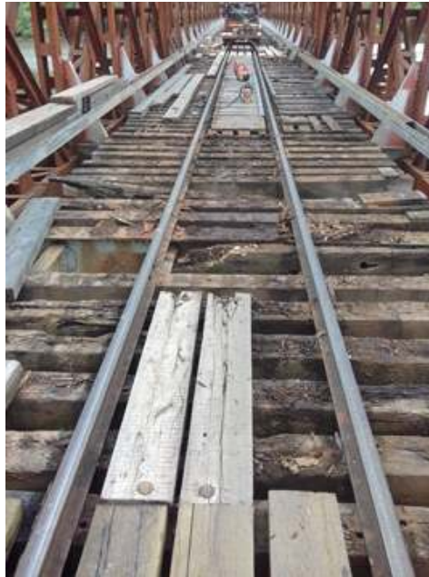
Os trabalhos de substituição dos dormentes na ponte sobre o Rio Pelotas
