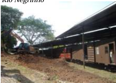
Terraplanagem onde será nova marcenaria e pintura
