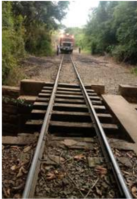
Equipamentos de via no trecho
