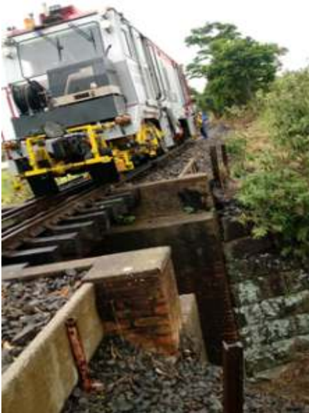
Equipamentos de via no trecho
