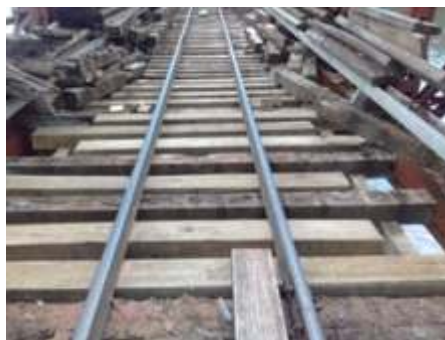
Os velhos dormentes aos poucos estão sendo trocados por novos que são talhados um a um
