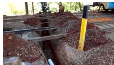
Os trabalhos de montagem de rede de canos para saída dos dejetos do novo sanitário
