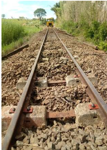
Dormentes substituídos na via permanente
