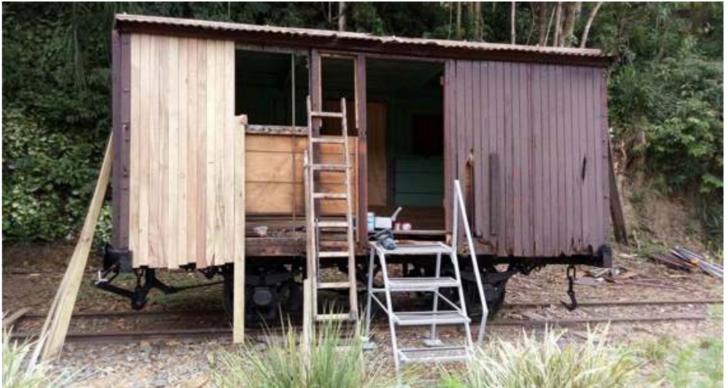
Reconstrução da parede lateral externa.
