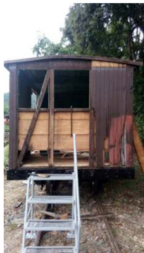
Trabalhando na reconstrução da parede de uma das cabeceiras.
