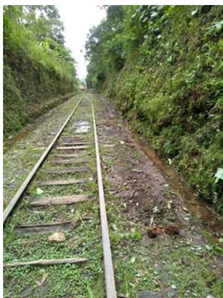
Limpeza da via no Km 24 - acesso ao túnel grande; devido à grande umidade, a vegetação cresce rapidamente.
