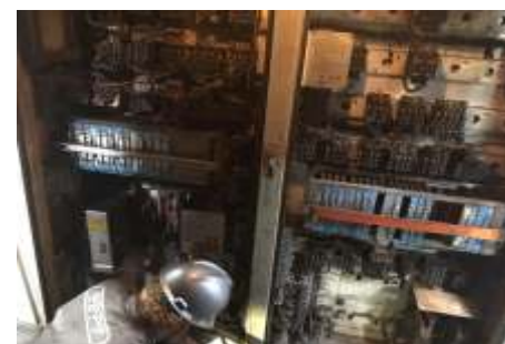
Trabalhos na C30-7A: revisão completa e instalação do ATC.
