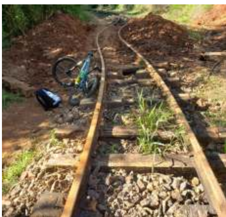
Dormentes já substituídos ao longo do km87
