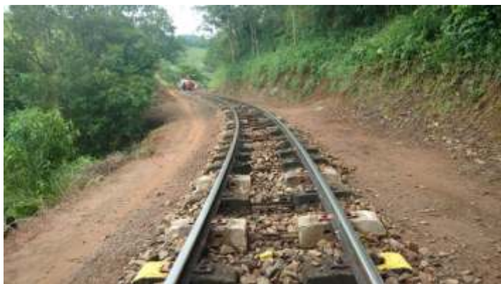
Dormentes já substituídos ao longo do km87
