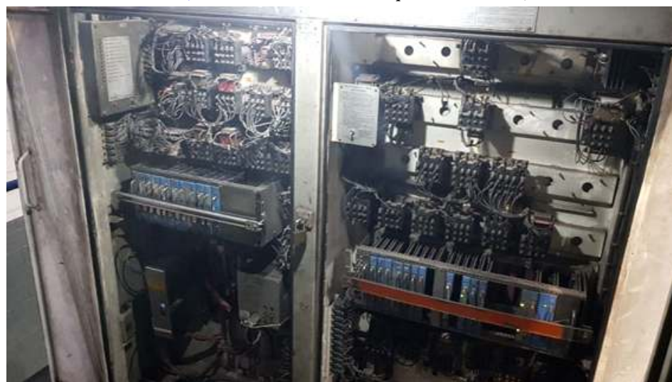
Nova iluminação instalada em todos os armários e gabinetes da C30
