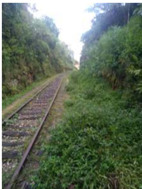
Limpeza da via no Km 24 - acesso ao túnel grande; devido à grande umidade, a vegetação cresce rapidamente.
